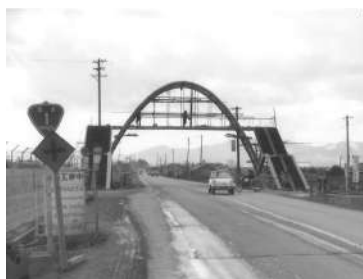
建設中の歩道橋（国道 1 号）
