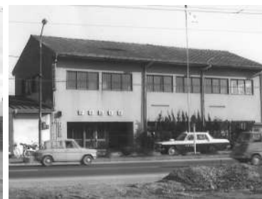
国道 1 号沿いの草津警察署
