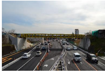
国道1号線隧道
