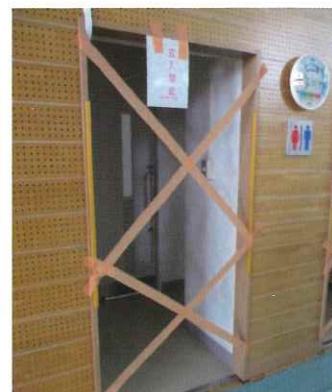
← 使用できないトイレの封鎖
