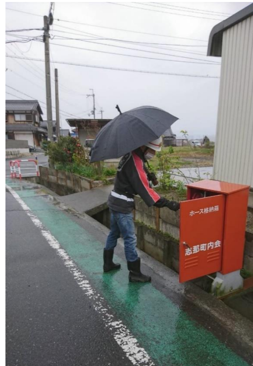
消火栓BOX点検
