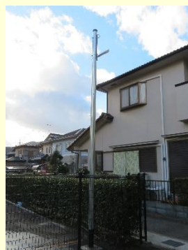
防犯灯の設置
